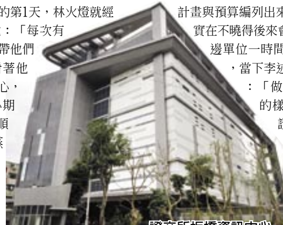
證交所板橋資訊中心
